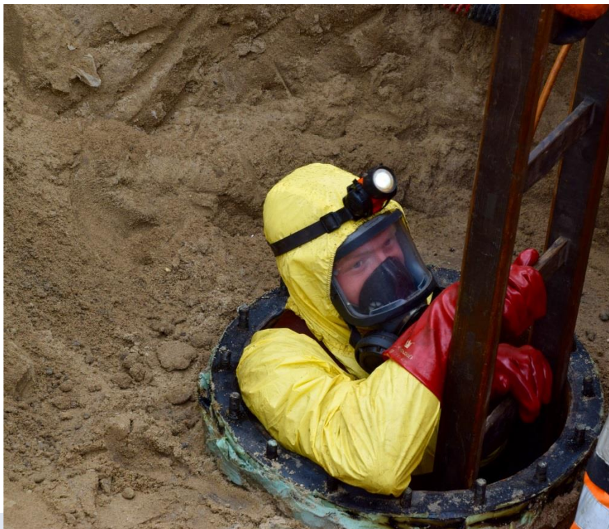
Foto 1: Het schoonmaken van de tank.
